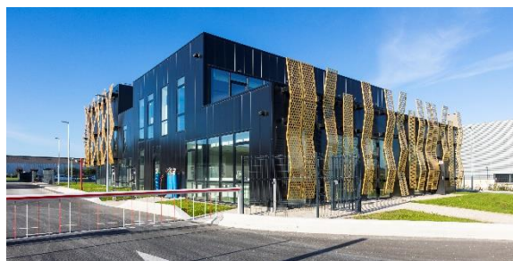
Le chai d'assemblage et les chais de stockage et de vieillissement de cognac développés sur 15 000 m 2 pour Distillerie de la Tour à Merpins (16). Livrés en décembre 2021.
